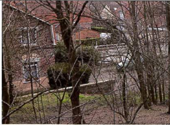
Photographie 1 : Vue du terril 71 en partie sud-ouest, mur de soutènement
