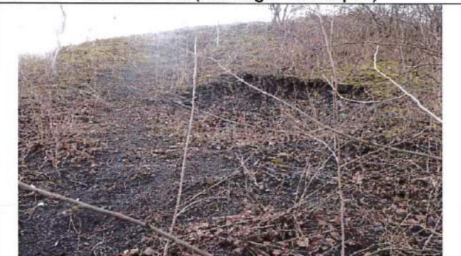
Photographie 4 : Vue du terril 71 en partie sud, désordre (glissement très superficiel) sur le cône
