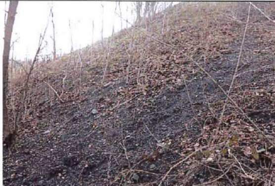
Photographie 5 : Vue du terril 71 en partie sud, traces de ravinement sur le cône
